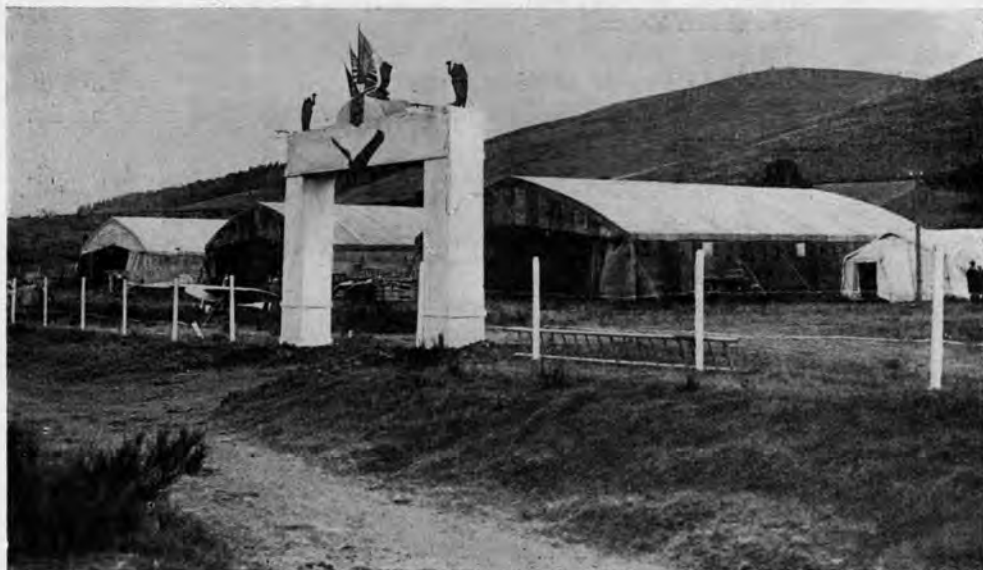
Le portique d'entrée.
