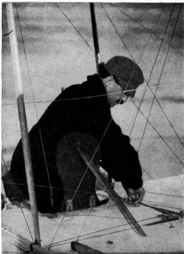
Le champion de 1911 règle ses câbles de gauchissement avant de repartir.
