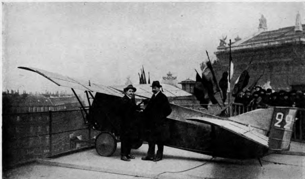
L'appareil du record exposé sur la terrasse des Galeries-Lafayette. A gauche : Alexis MANEYROL ; à droite Louis PEYRET.
