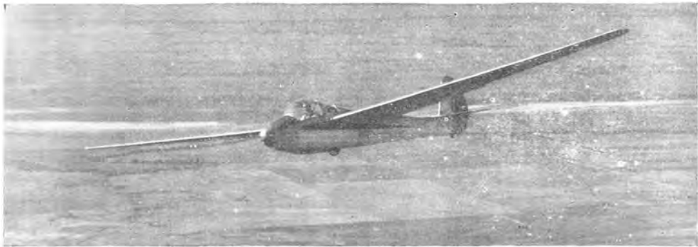
Le racer américain « Schweitzer » à water ballasts, entièrement métallique.
