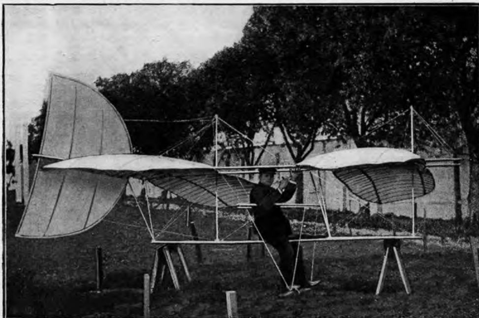
Le « Santa Clara » modifié (1906), piloté par MONTGOMERY. La timonerie de gauchissement, perfectionnée, comportait un rappel des ailes par le haut.
